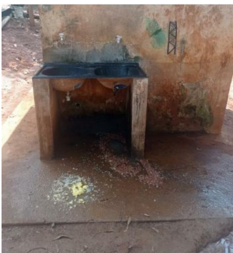
Figura 32 - Foto de tanque sem sifão e restos de alimentos na área externa dos banheiros coletivos
