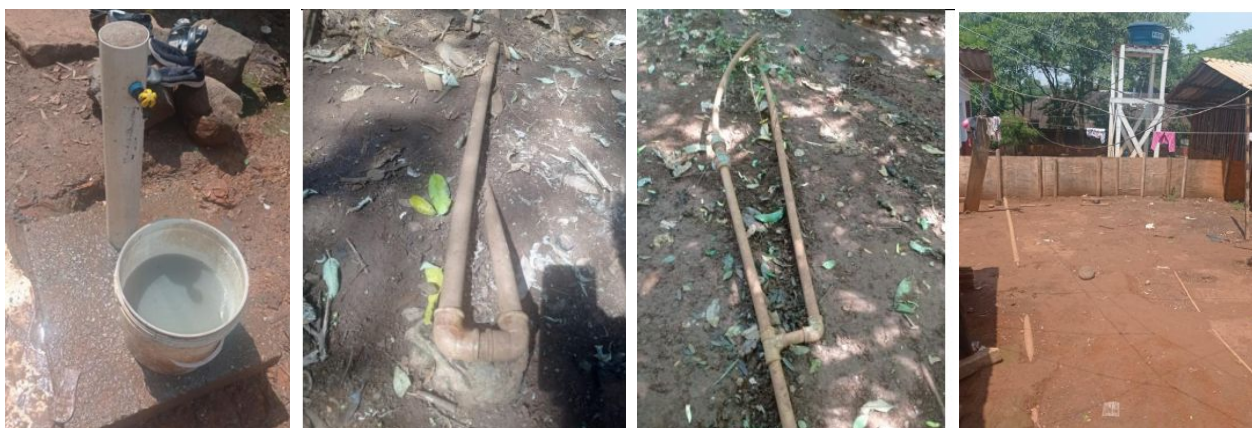
Figura 25, 26, 27 e 28 - Fotos de exemplo das estruturas de água levantadas. Da esquerda para a direita: Chafariz e pontos de água, condição dos cotovelos e derivações do sistema de encanamentos e tubulações expostas.
